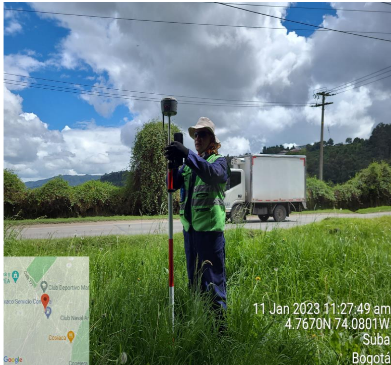
Fotografía 6. Levantamiento de información de la tubería de 14" de la red de VANTI, con equipo de detección de VANTI, en el municipio de Cota.
